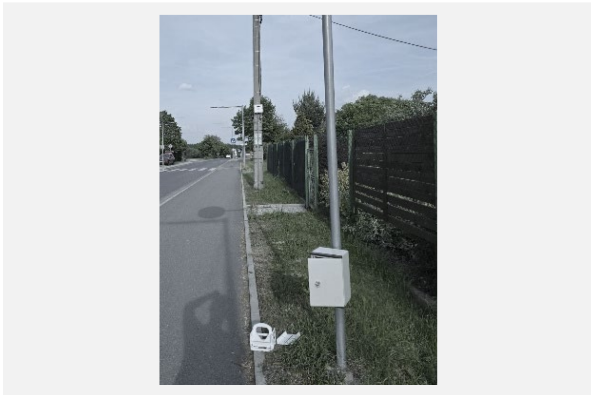
Obr. 12: Profil 4 – Měřicí zařízení (radar) 6
